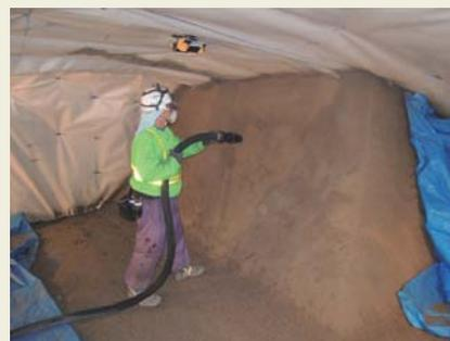
土質系埋戻し材の上部空間の吹付け閉鎖施工試験
