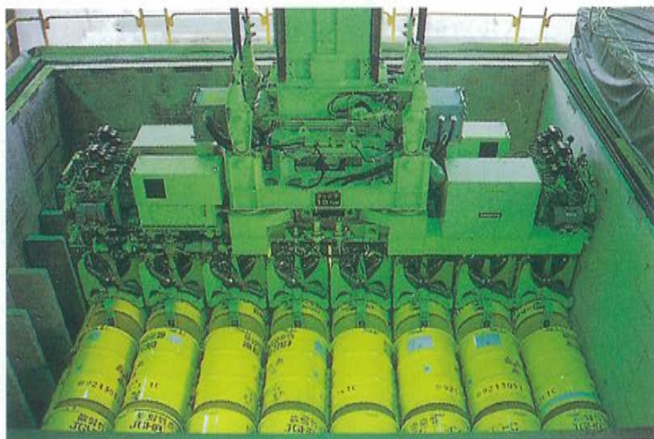
処分ビット内への廃棄体定置状況
