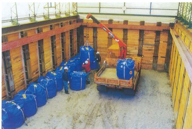
トレンチ内への廃棄物定置状況
