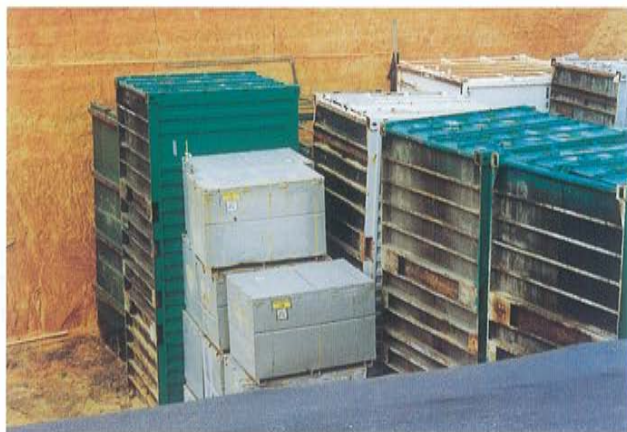
ISO 20フィートコンテナと金属箱廃棄体の処分状況 (クラスA廃棄物)
